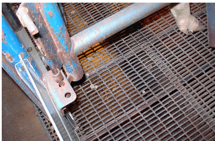
FOTO 2: SISTEMA DE PISO EMPARRILLADO O “SLAT”
